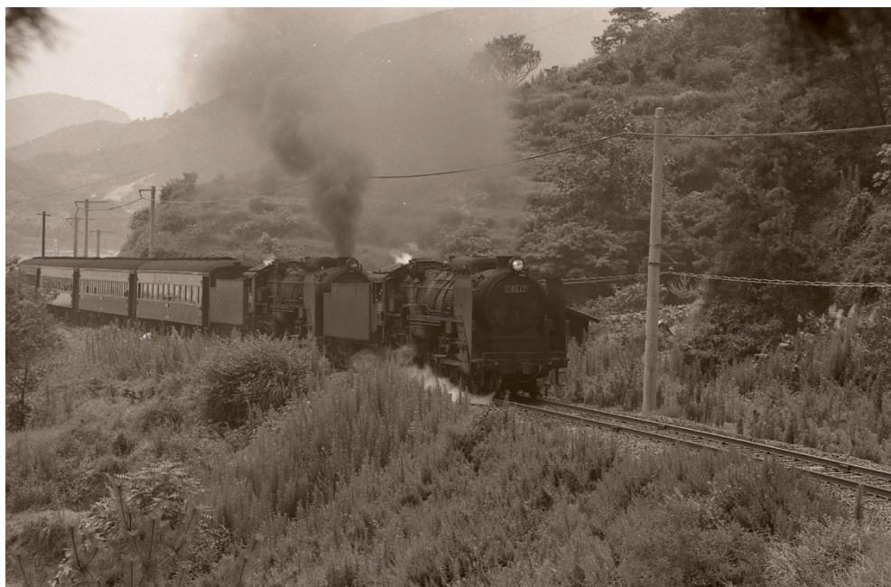
C6217+C6241号機牽引の626レ (安芸川尻～安登, 1969年7月)
