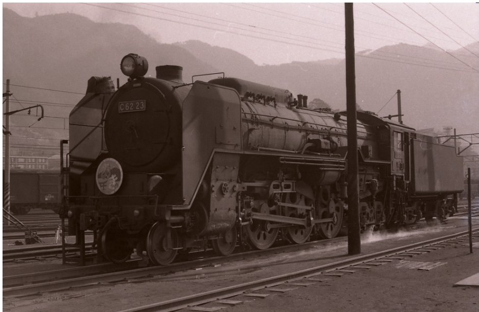
“常磐の女王” C6223号機 糸崎機関区にて 1969年3月撮影
