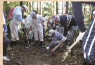
萱野峠敷石掘り作業風景
