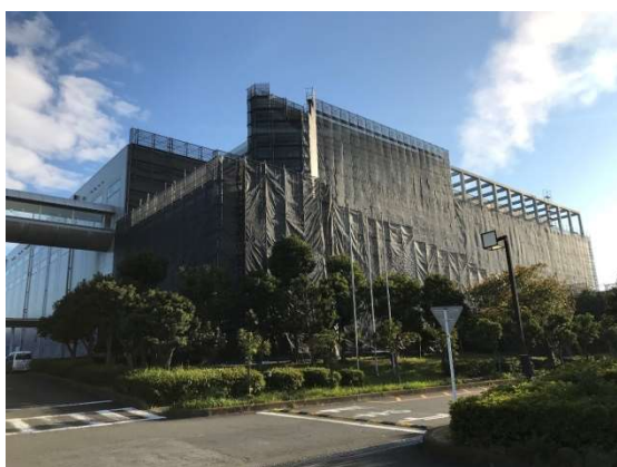
建屋の外壁補修工事を行う浮島処理センター
