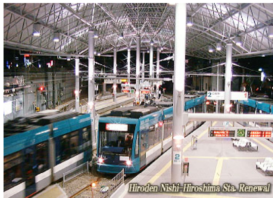
図-5 広島電鉄西広島駅 LRVは駅のホームを全て低く 改造しなければならない
