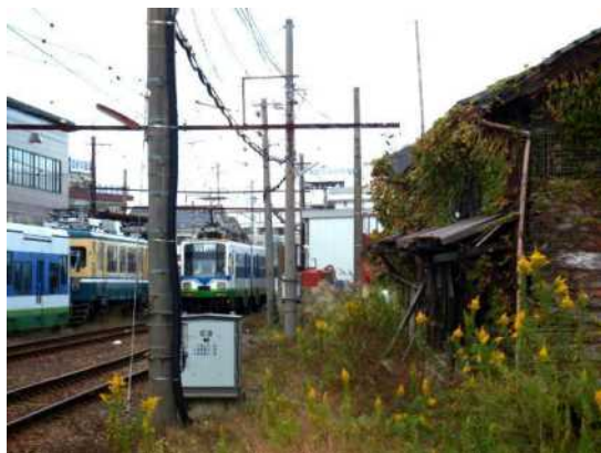
写真-⑭ 大協石油武生油槽所専用線跡 北府駅 手前から3本目の架線柱が本線より1線分離して立っている 平成30年10月14日
