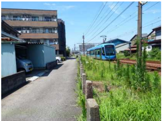
写真-① 福井新駅南方約180m地点 1線分の空き地が側線跡 撮影はいずれも平成30年7月16日または8月4日
