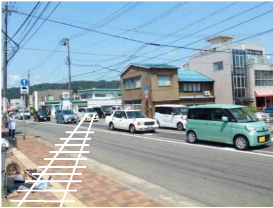
写真-⑦ 日赤病院前通り 跡地上に福井トヨベットが建つ。この広い道路はもっと狭く、線路と交差する木田銀座商店街ともう1本の路地に、後年は踏切警報機があった
