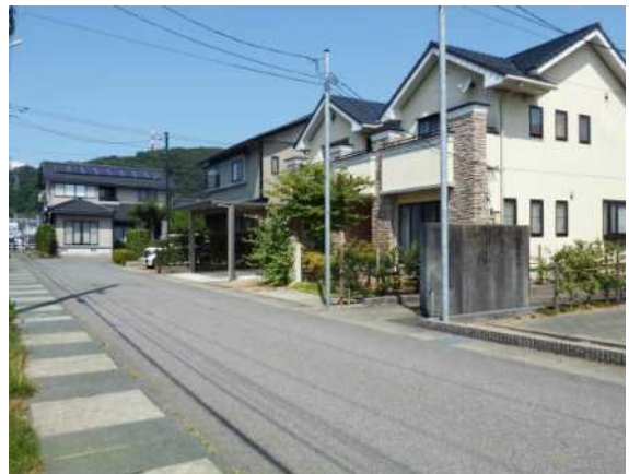
写真-⑫ 工場内で直角に曲がりさらに奥へと進むが、全く痕跡を残さず再開発されている
