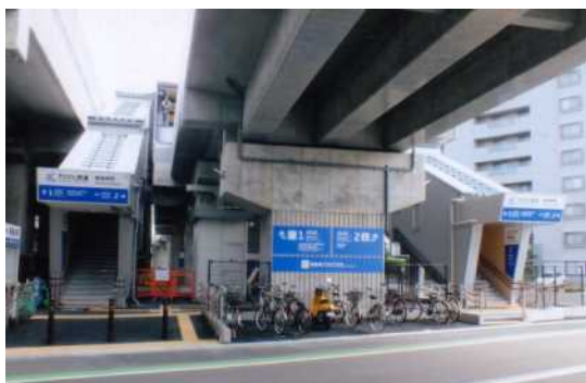
写真-3 新福井駅外観 平成30年8月13日 ている。
