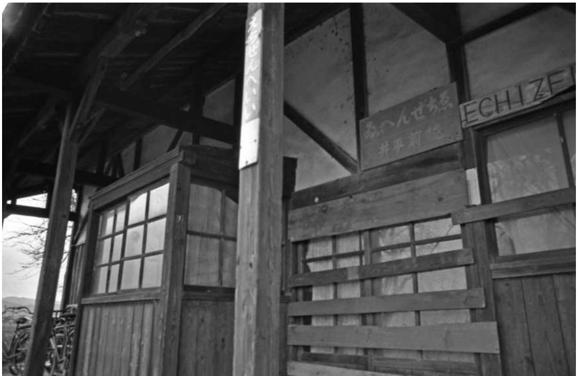
写真-1 越前平井駅 昭和48年3月18日 木製の駅名標に注視
