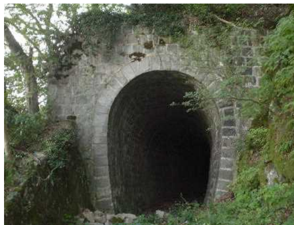
写真-4 越前電鉄 初代・下荒井トンネル (参考) 大正3年竣工 勝山市
