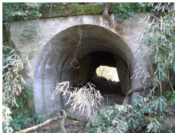
写真-3 正円に近いトンネルは単線鉄道用としては異例。高さも低い。
