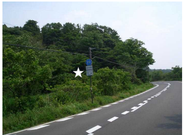
写真-1 吉崎側よりトンネル方向を望む。 藪に覆われてトンネルは見えないが、☆印を付したあたりに掘られている。
