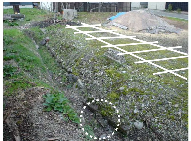
写真-21 大野口駅手前に残る線路跡
