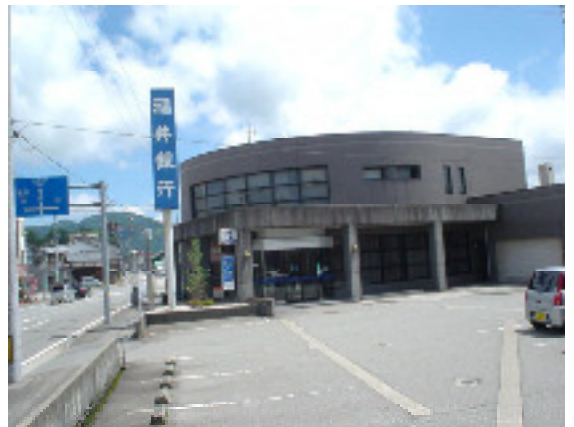
写真-24 京福大野駅跡 当時の駅ビルよりは少し後退している
