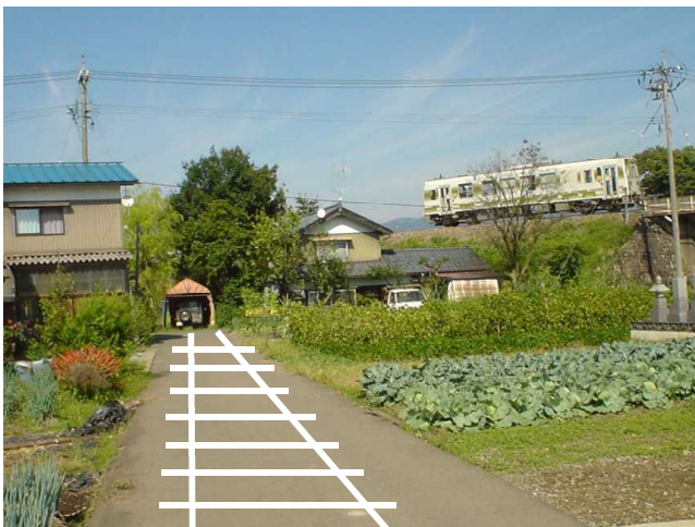
写真-20 越美北線架道橋を大野側から見る 線路跡が生活道路となっている
