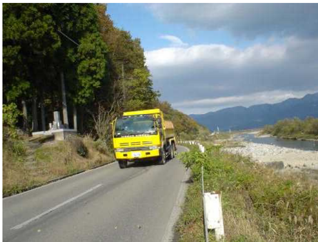
写真-9 嶗崎～下荒井六呂師口間 道路が大きく改修され痕跡は何もない
